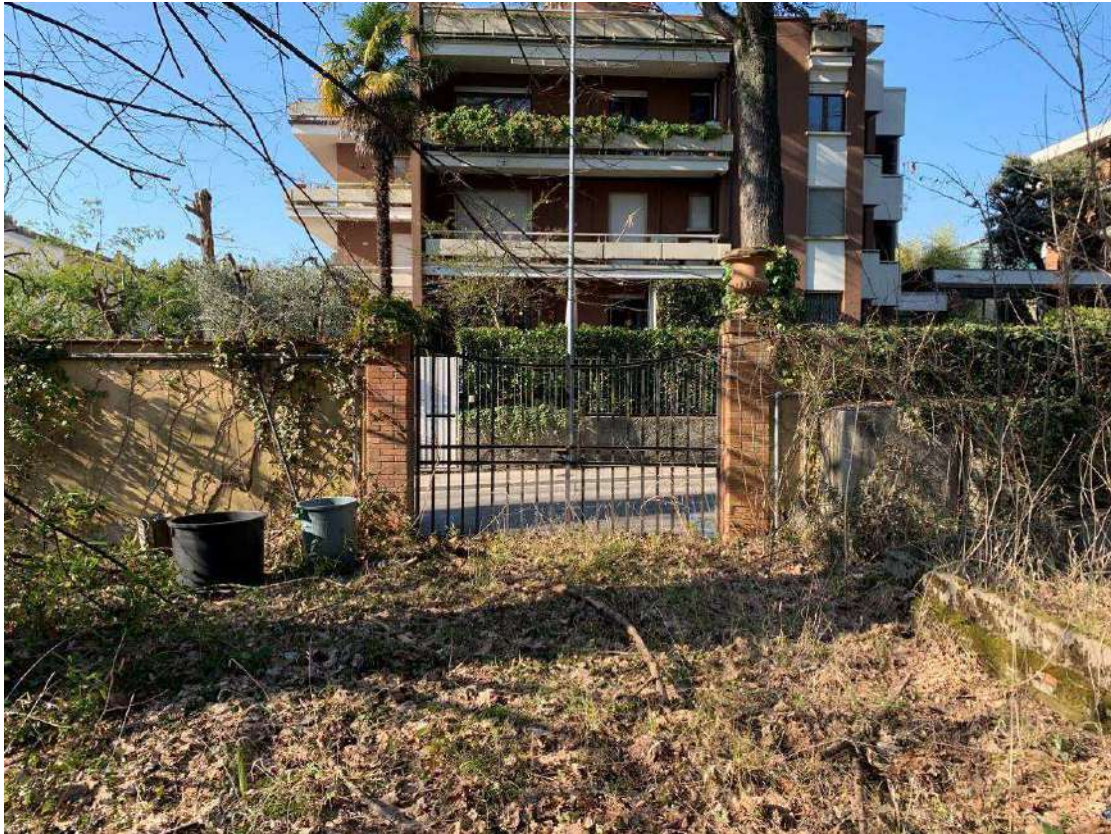
CANCELLO DI ACCESSO DALLA VIA PIETRO BARAGIOLA
